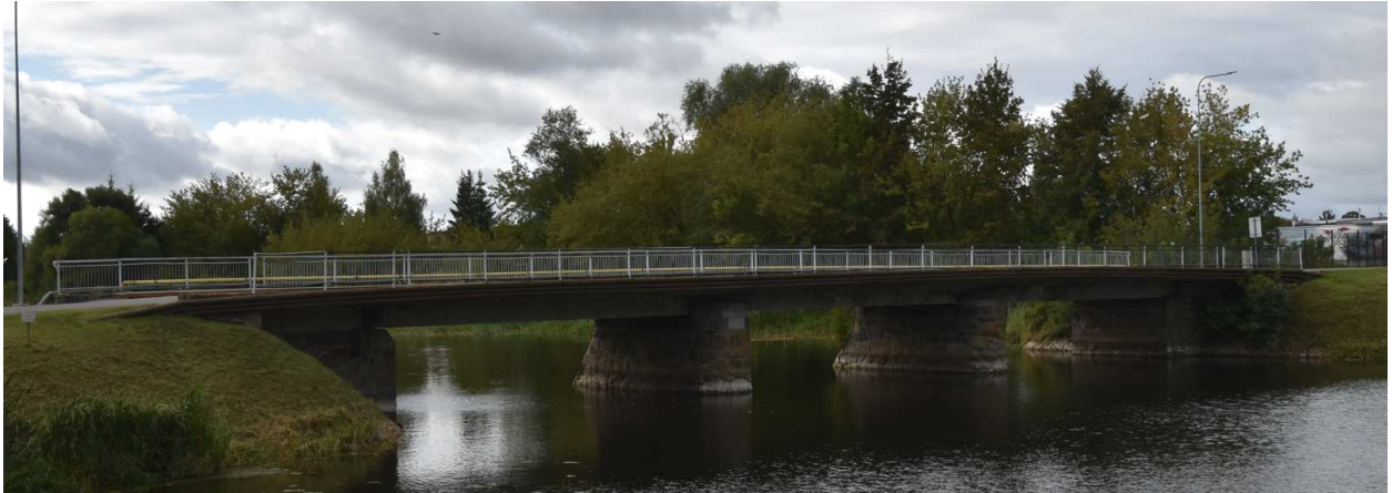
2 pav. Tiltas per Nevėžį vaizdas iš žemupio pusės kairiojo upės kranto, 2022 m.
