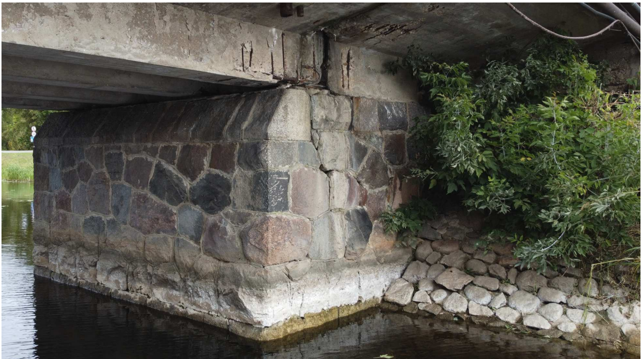
11 pav. Atrama Nr. 4 (kairiajame upės krante) – tašytų akmenų ramtas (numatomas remontuoti). Šlaitas sutvirtintas akmenimis. 2022 m.
