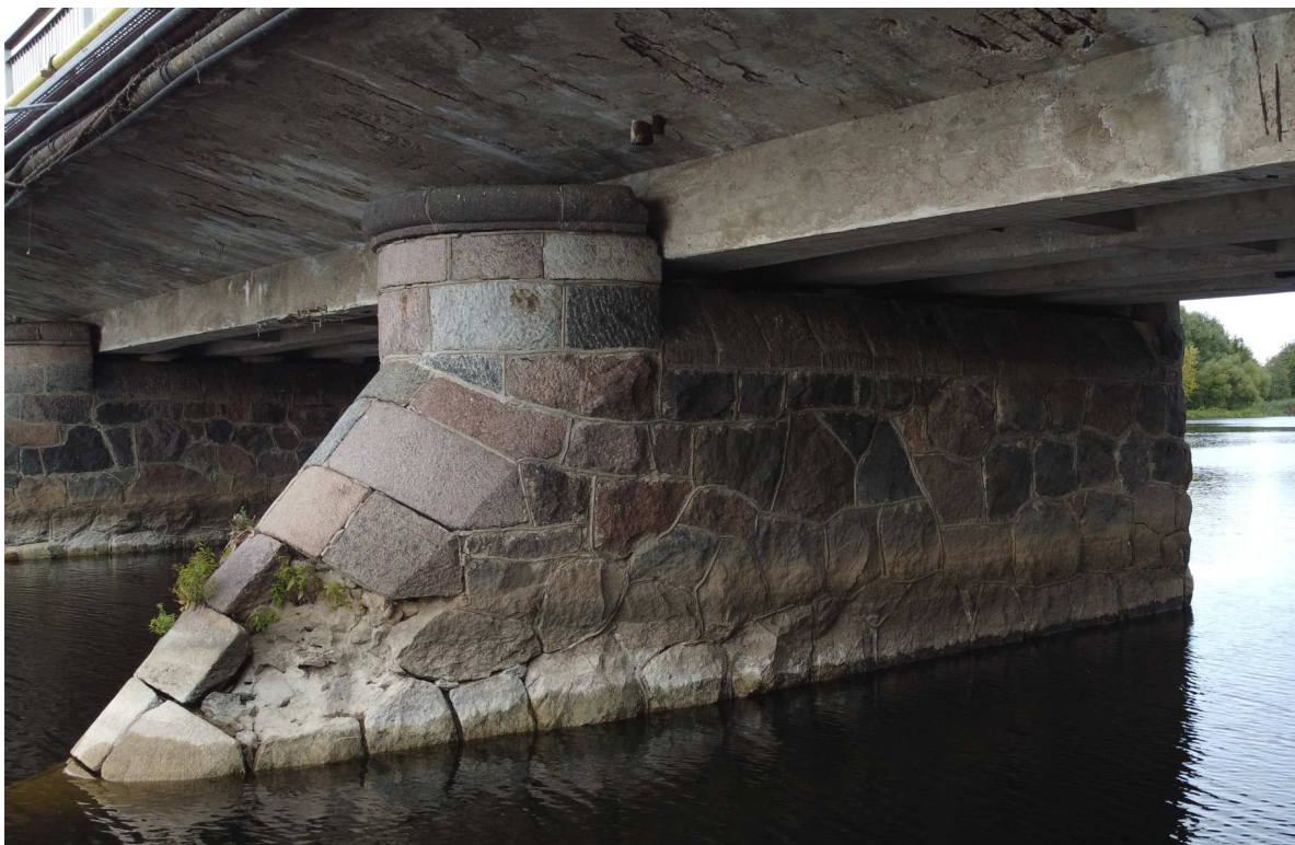
9 pav. Atrama Nr. 3 - tašytų akmenų tauras (numatomas remontuoti). Vaizdas į lytlaužą. 2022 m.
