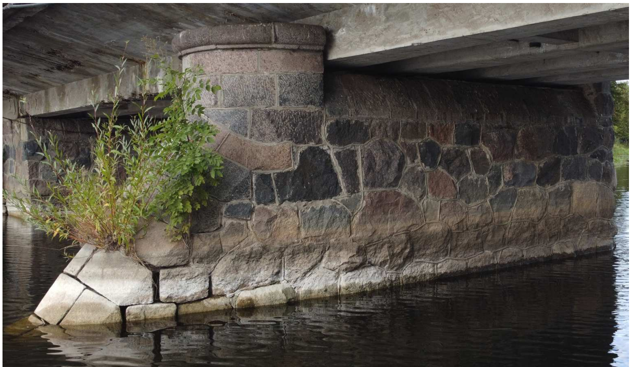
7 pav. Atrama Nr. 2 - tašytų akmenų tauras (numatomas remontuoti). Vaizdas į lytlaužą. 2022 m.
