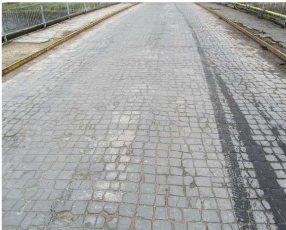
13 pav. Grandinio dangą ant tilto prieš užasfaltavimą. 2018 m.
