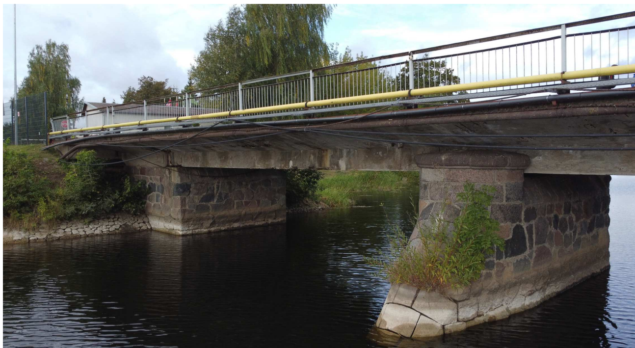
4 pav. Pirmasis tilto tarpatramis. 2022 m
