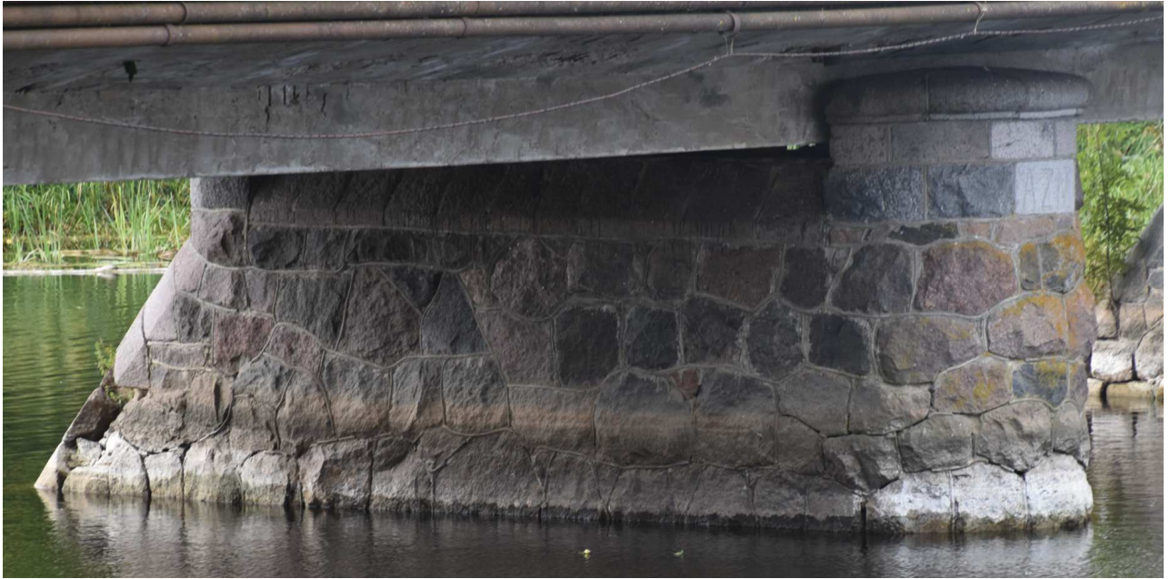
10 pav. Atrama Nr. 3 - tašytų akmenų tauras (numatomas remontuoti). Vaizdas į žemupio pusės dalį. Ant atramos iškalta raidės AZM (tikėtina tilto statybos metu Pajuosčio dvaro savininko Aleksandro ir jo žmonos Zofijos Meištaivičių vardų ir pavardės inicialai). 2022 m.
